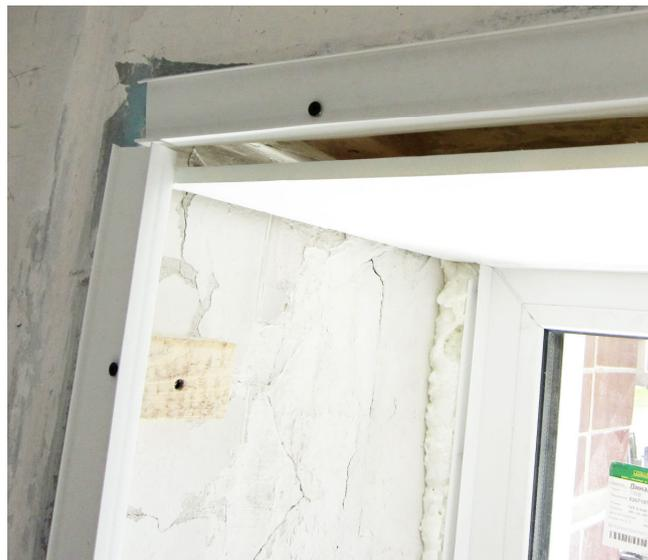
2. Прикручиваем (прижимаем) панель 3045 к подложке 4056.
